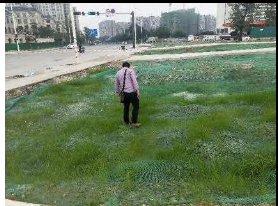
2#监测点-元华车辆段出入段线区间
