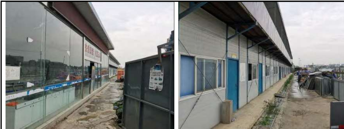
插图 1.1-11 土建 2 标项目部
