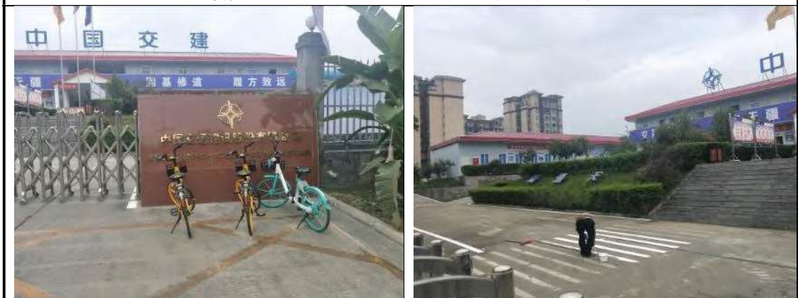
插图 1.1-10 土建 1 标 (三分部) 项目部
