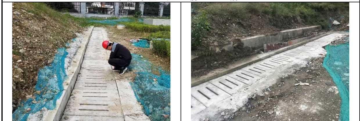
车站工程区（截水沟）
