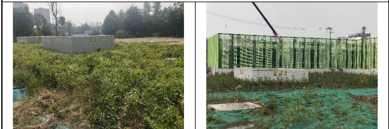
车站工程区（表土回覆、防尘网遮盖）
