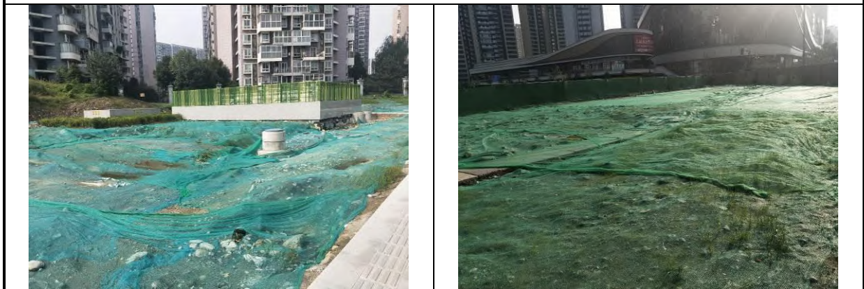
车站工程区（表土回覆、防尘网遮盖）
