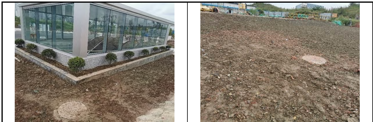
车站工程区（表土回覆、土地整治）
