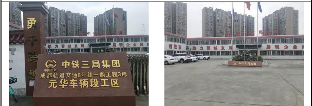
土建 3 标项目部
