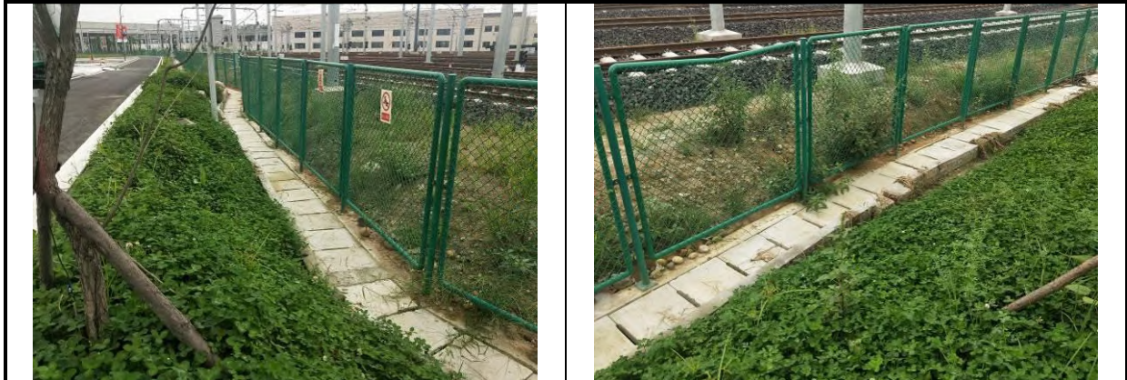
车辆段工程区（排水沟）
