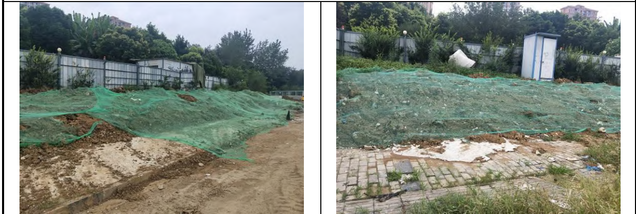
区间工程区（表土回覆、防尘网遮盖）
