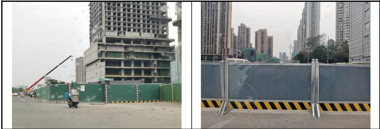
区间工程区（彩钢板围栏）
