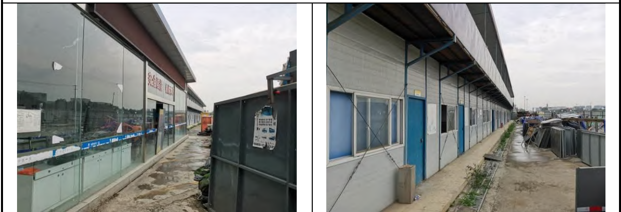
土建 2 标项目部
