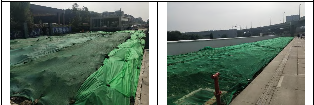
车站工程区（表土回覆、防尘网遮盖）
