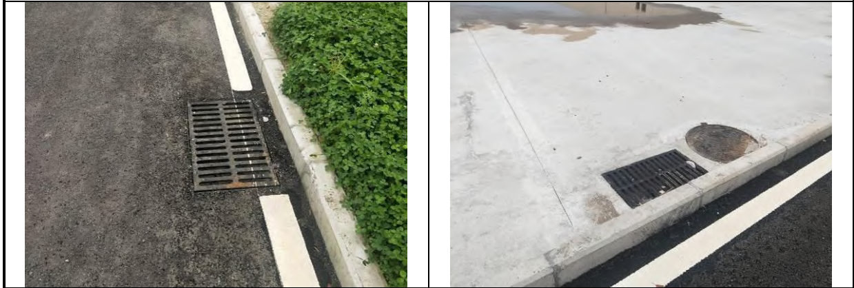
车辆段工程区（雨水口）
