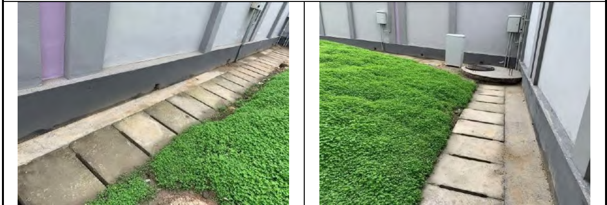
插图 3.5.2-58 车辆段与主变工程区（回龙停车场排水沟及景观绿化）
