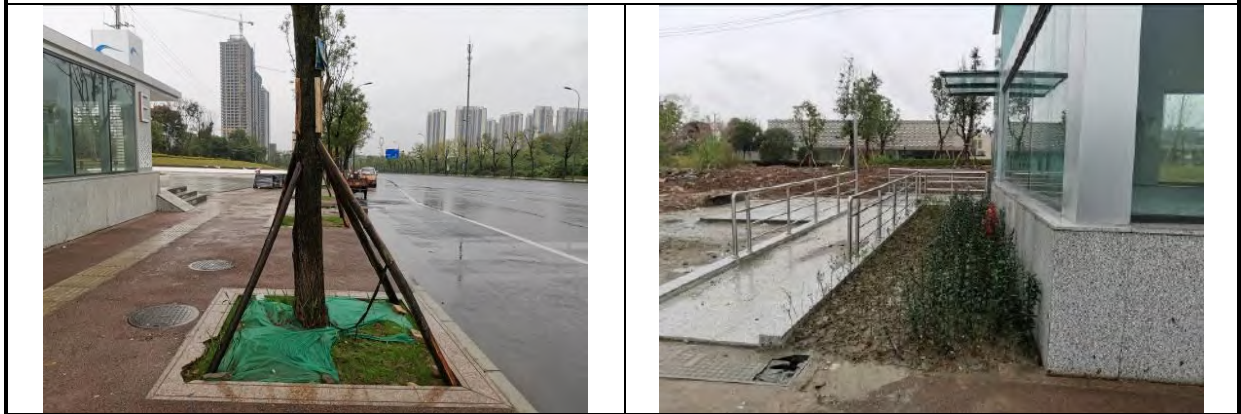
插图 3.5.2-24 车站工程区（沈阳路站景观绿化、防尘网苫盖）
