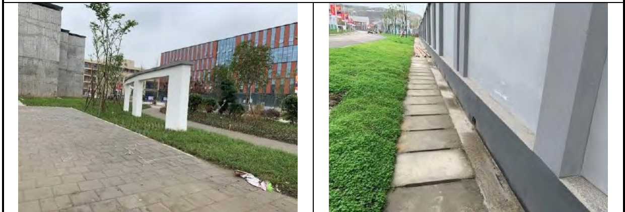
插图 3.5.2-59 车辆段与主变工程区（回龙停车场排水沟及景观绿化）
