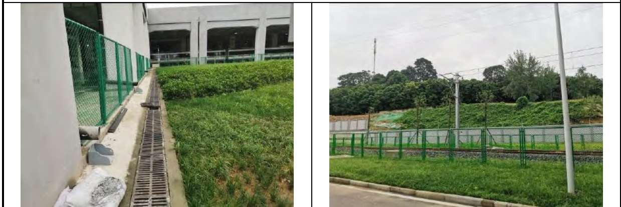
插图 3.5.2-75 车辆段与主变工程区（回龙停车场排水沟）
