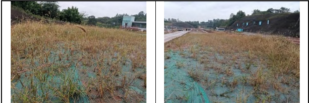
插图 3.5.2-23 车站工程区（钓鱼嘴站植被恢复、临时苫盖）
