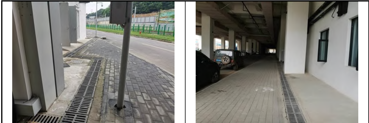
插图 3.5.2-73 车辆段与主变工程区（回龙停车场排水沟）
