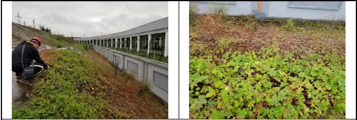
车辆段与主变工程区 植被建设工程
