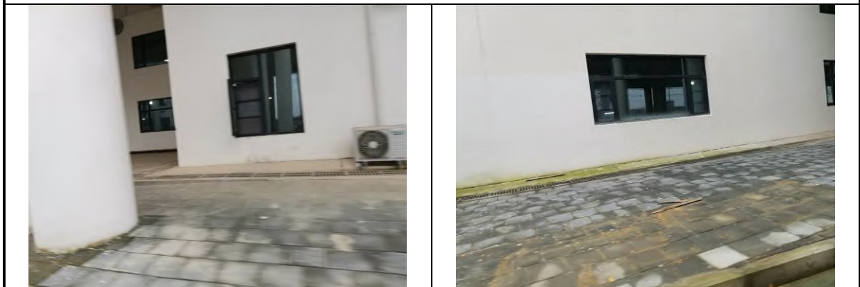
插图 3.5.2-68 车辆段与主变工程区（回龙停车场排水沟）
