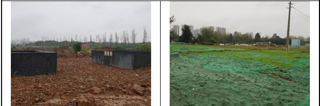
插图 3.5.2-4 区间工程区（土地整治及绿化覆土）
