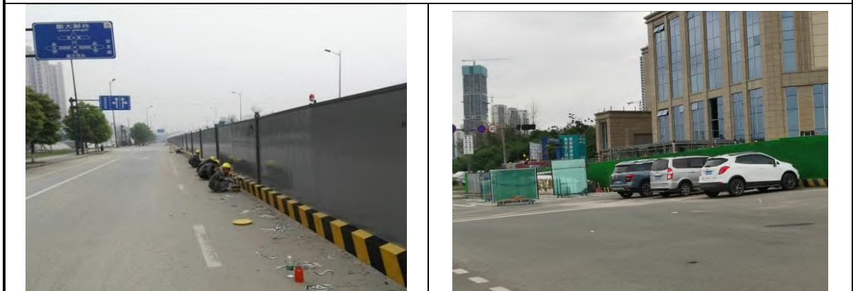
插图 3.5.2-9 区间工程区（彩钢板围挡）
