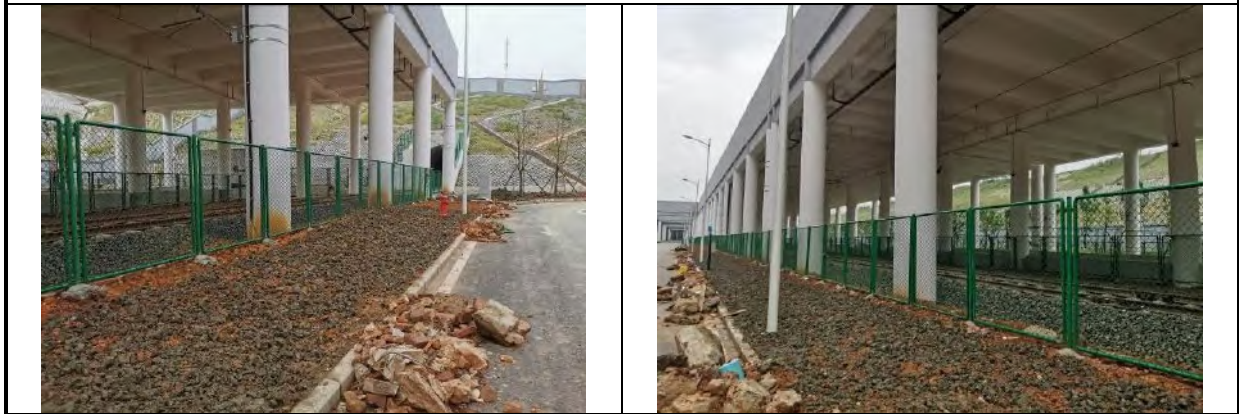
插图 3.5.2-66 车辆段与主变工程区（回龙停车场表土回覆及土地整治化）
