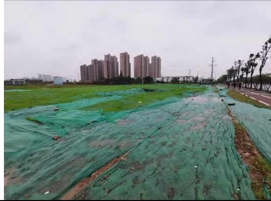
插图 3.5.2-31 车站工程区（植被恢复、防尘网苫盖）
