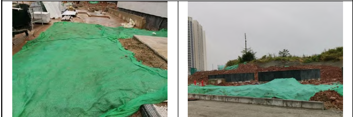
插图 3.5.2-16 车站工程区（杭州路站土地整治、绿化覆土、防尘网苫盖）
