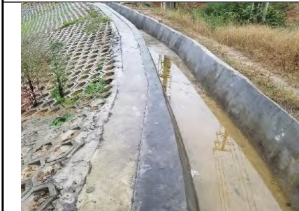
车辆段与主变工程区 防洪排导工程
