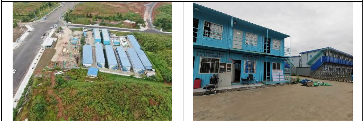
插图 3.5.2-49 车站工程区（1 标项目部临时排水）
