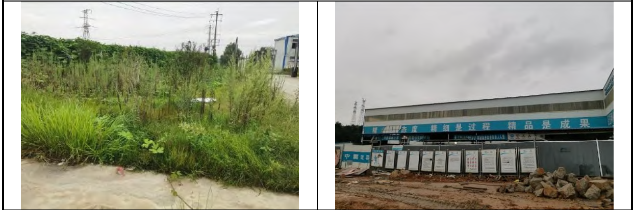
插图 1.1.4-42 土建 6 标钢筋加工棚 (2020 年 10 月)
