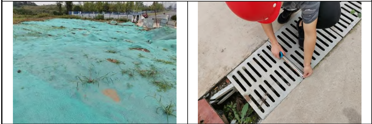
插图 3.5.2-52 车站工程区（4 标项目部临时绿化、临时排水、临时苫盖）
