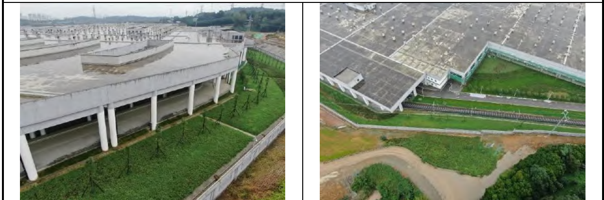
插图 3.5.2-63 车辆段与主变工程区（回龙停车场表土回覆及景观绿化）
