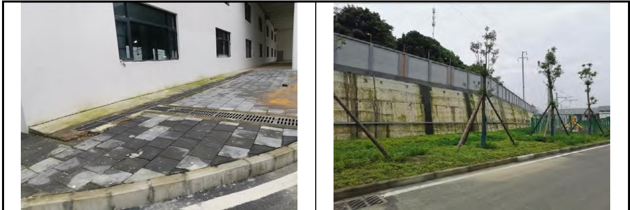
插图 3.5.2-69 车辆段与主变工程区（回龙停车场排水沟）
