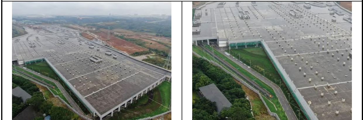
插图 3.5.2-64 车辆段与主变工程区（回龙停车场表土回覆及景观绿化）
