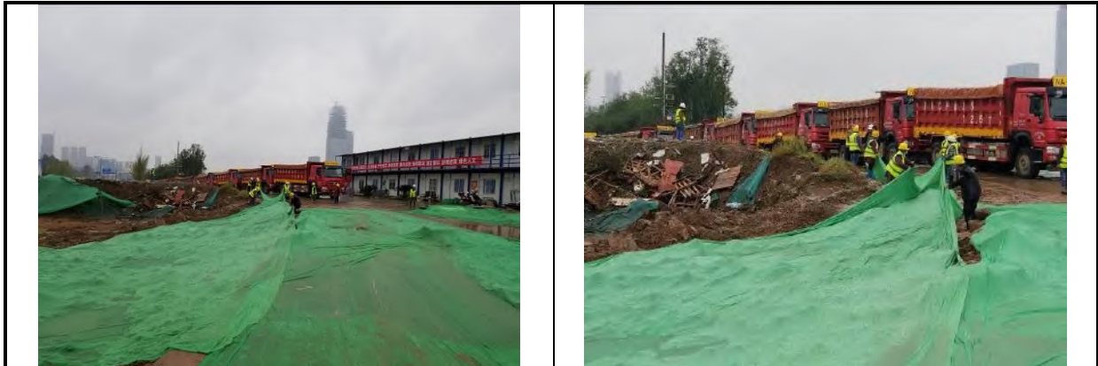
插图 3.5.2-15 车站工程区（秦皇寺站临时苫盖）
