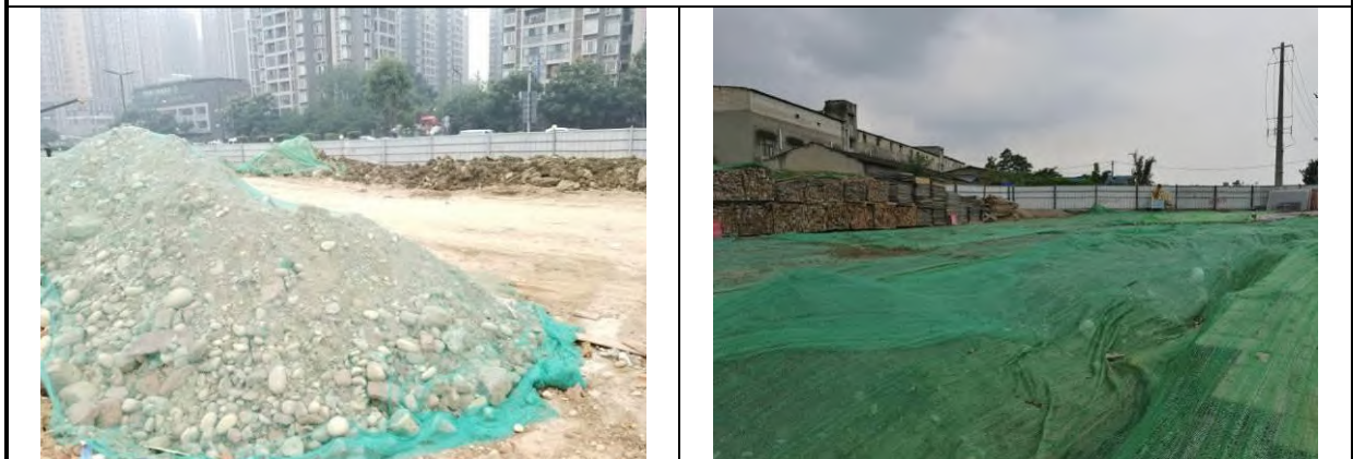
插图 3.5.2-13 区间工程区（防尘网遮盖）
