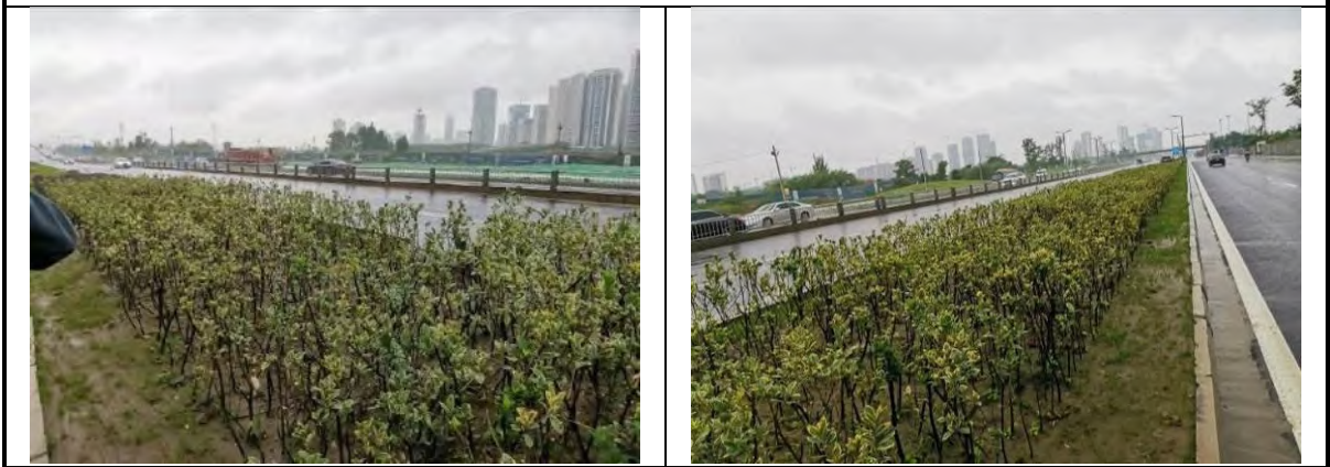
区间工程区 植被建设工程
