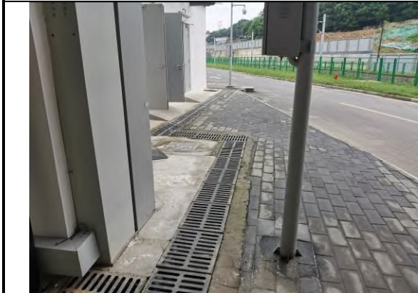
车辆段与主变工程区 防洪排导工程
