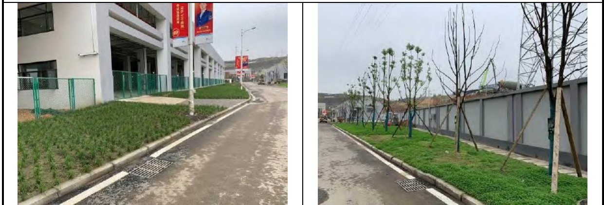
插图 3.5.2-60 车辆段与主变工程区（回龙停车场表土回覆及景观绿化）
