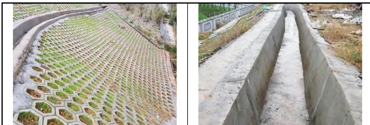
插图 3.5.2-77 车辆段与主变工程区（六棱砖植草护坡、截水沟）
