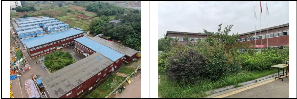
插图 3.5.2-53 车站工程区（5 标项目部临时绿化）
