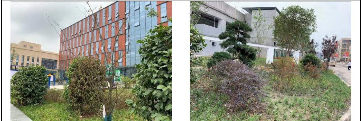
插图 3.5.2-62 车辆段与主变工程区（回龙停车场表土回覆及景观绿化）
