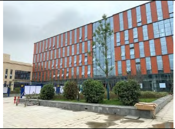
插图 1.1.4-29 回龙停车场综合楼前景绿化
