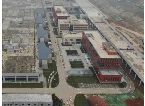
插图 1.1.4-31 综合楼、运检楼、运用库
