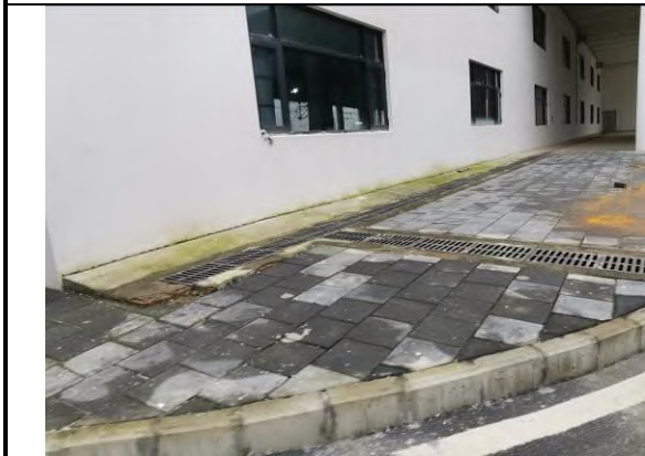
车辆段与主变工程区 防洪排导工程
