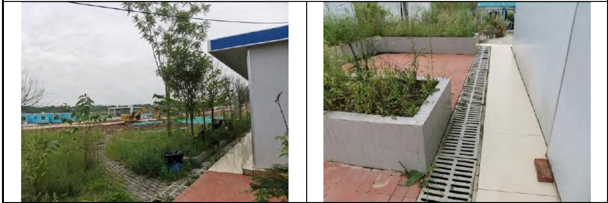
插图 3.5.2-52 车站工程区（4 标项目部临时绿化、临时排水）
