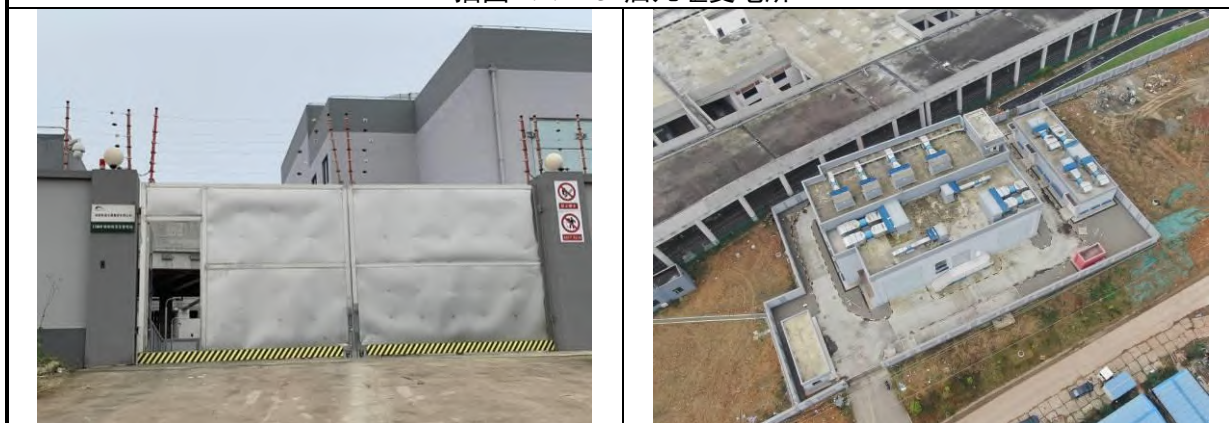
插图 1.1.4-24 回龙主变电站
