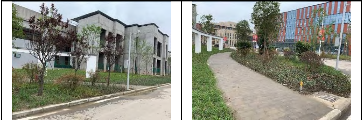
插图 3.5.2-61 车辆段与主变工程区（回龙停车场表土回覆及景观绿化）
