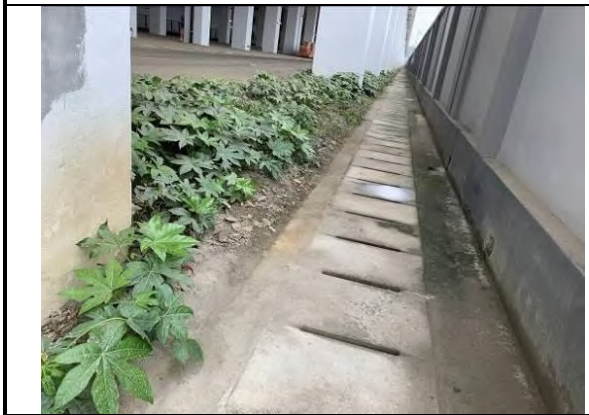
车辆段与主变工程区 防洪排导工程
