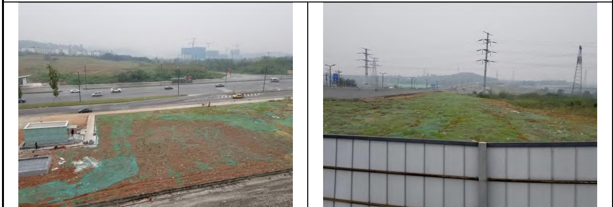
插图 3.5.2-12 区间工程区（防尘网遮盖）
