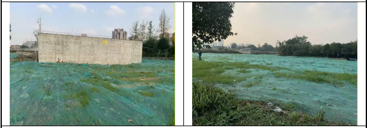
区间工程区 植被建设工程
