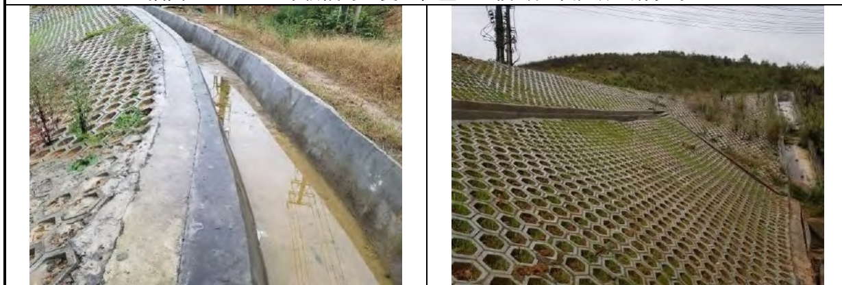
插图 3.5.2-78 车辆段与主变工程区（六棱砖植草护坡、截水沟）
