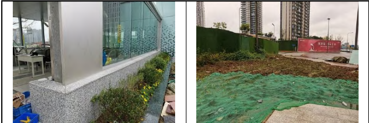
插图 3.5.2-43 车站工程区（新通大道站景观绿化、防尘网苫盖）
